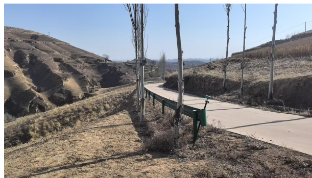
峪 97 现有进场道路
