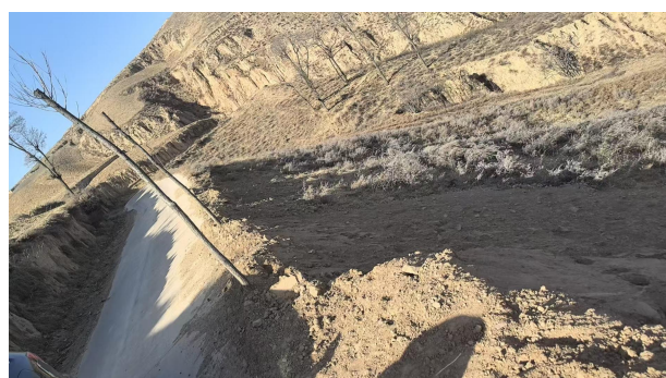
峪 96 现有进场道路
