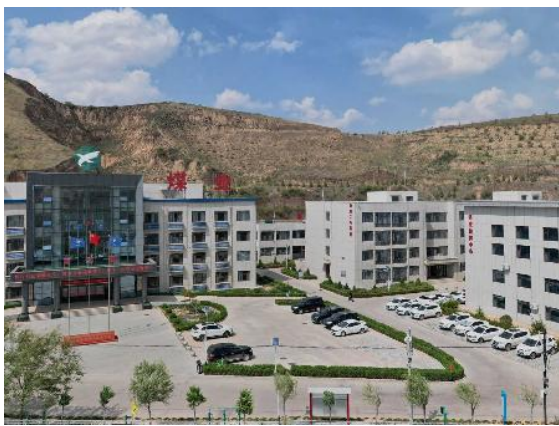
场地北侧办公生活区
