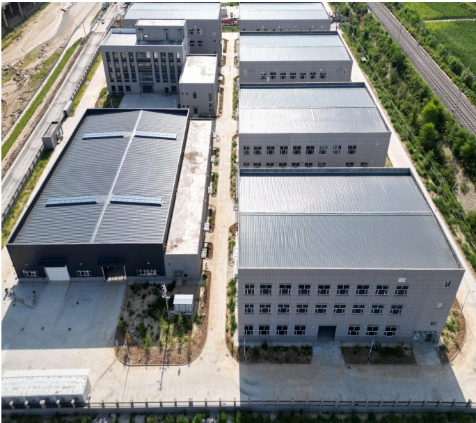
项目供热厂房及办公楼现状
