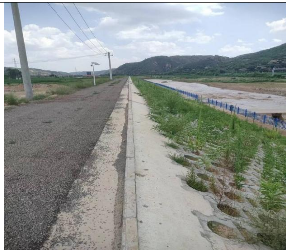
南侧沿岸河堤
