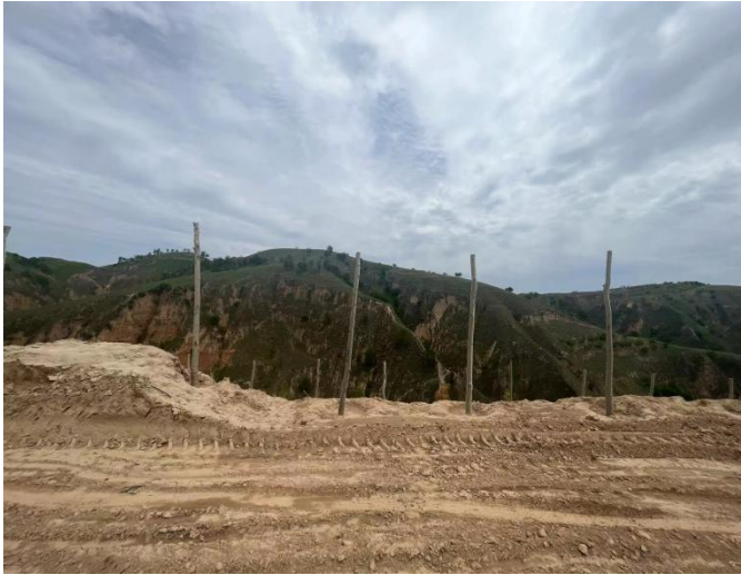
项目东侧现状
