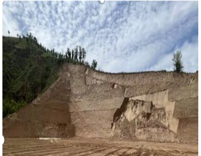
项目西侧现状
