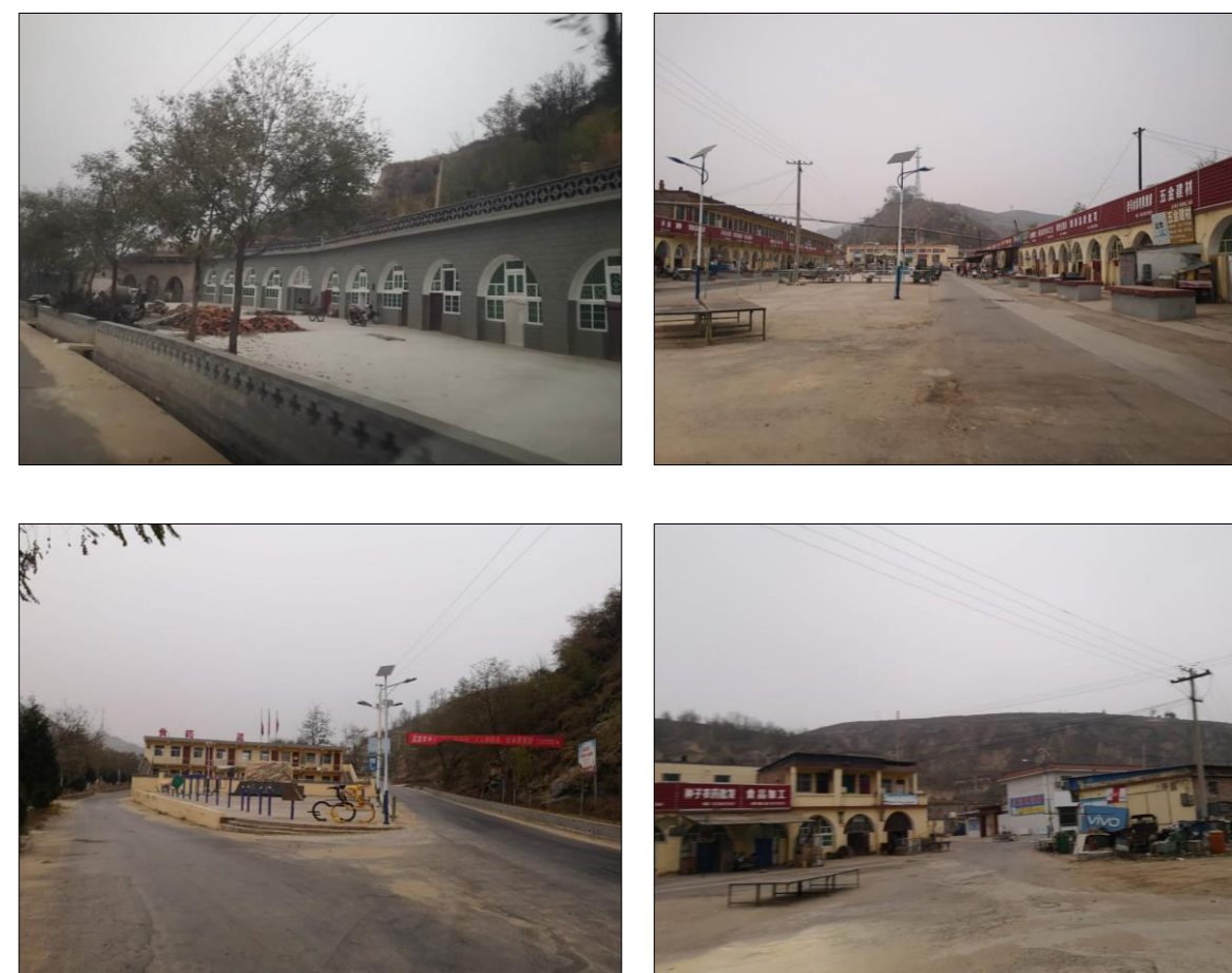
图 2.2-7 三川口镇居民及污水治理设施现状
