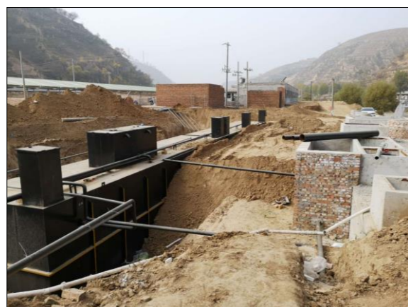
老君殿镇污水处理站（在建）
