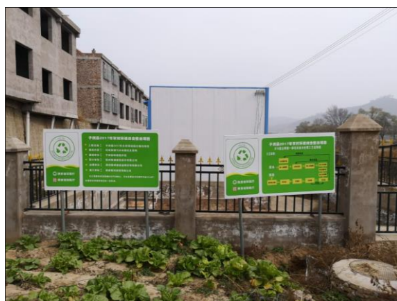
何家集镇污水处理站
