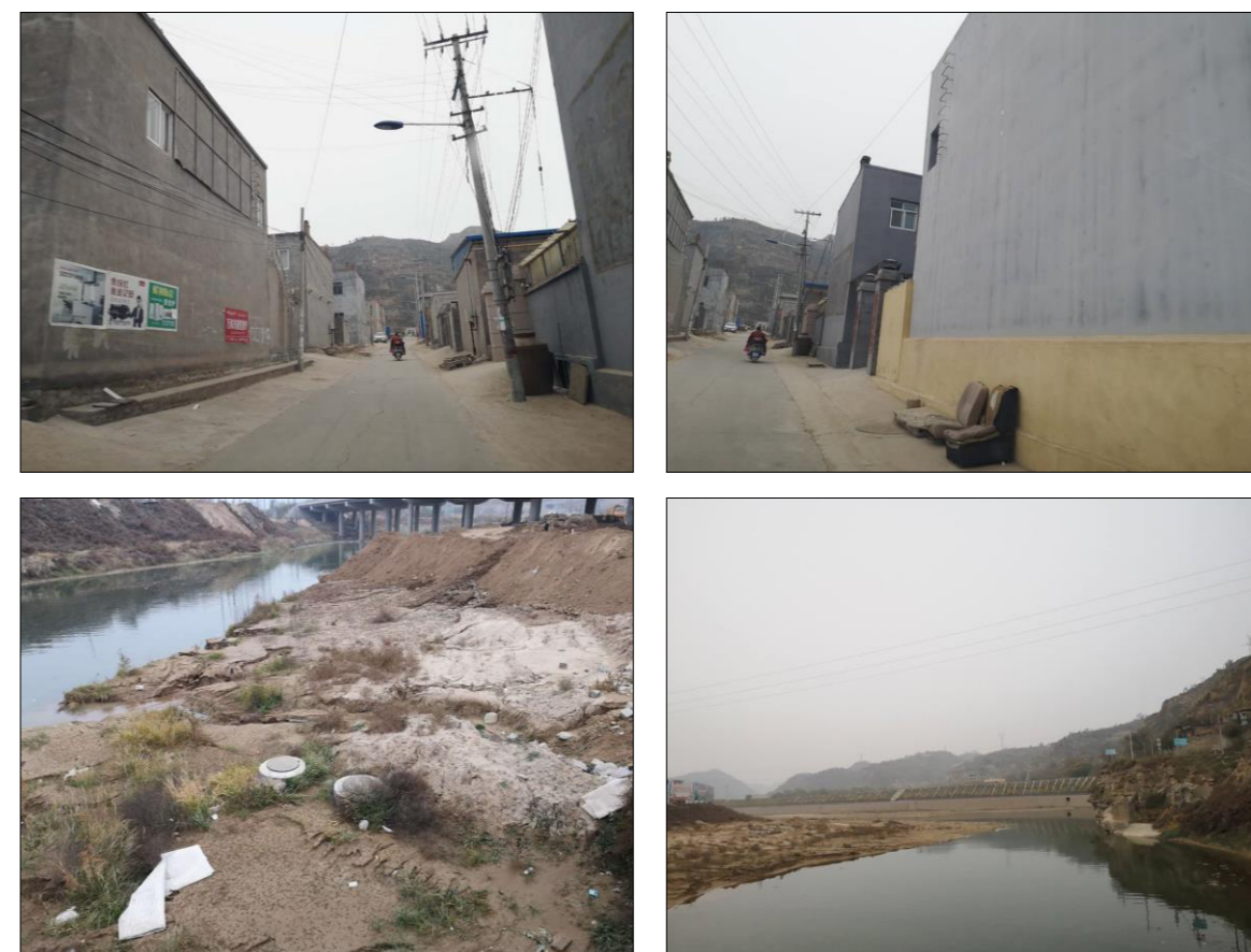
图 2.2-1 双湖峪街道办污水管网及大理河现状
