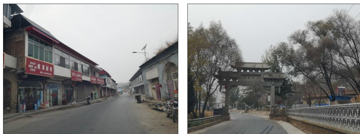
图 2.2-4 裴家湾镇居民及污水治理设施建设现状
