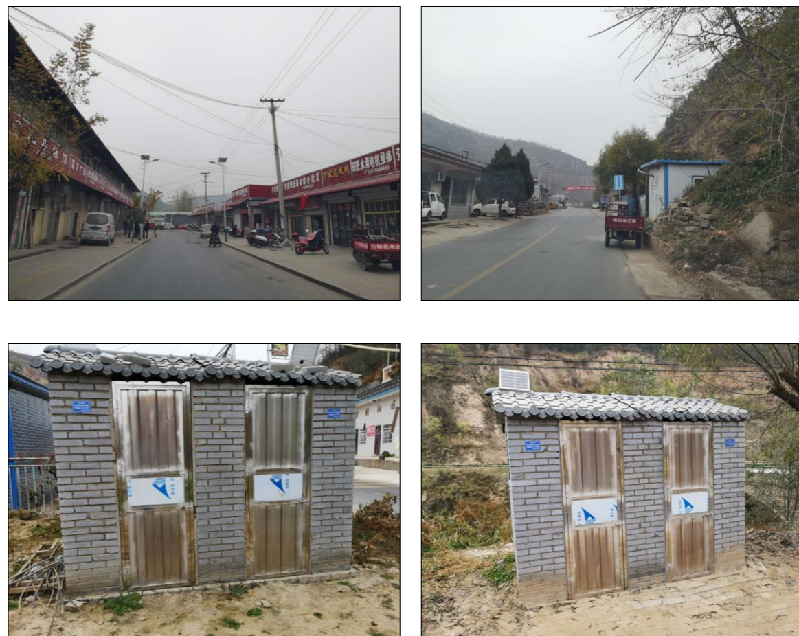
图 2.2-6 苗家坪镇居民及污水治理设施现状
