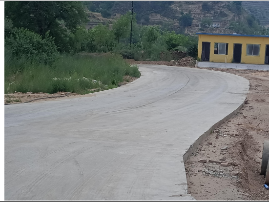
项目南侧及进场道路硬化
