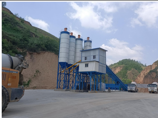
项目已建成搅拌楼
