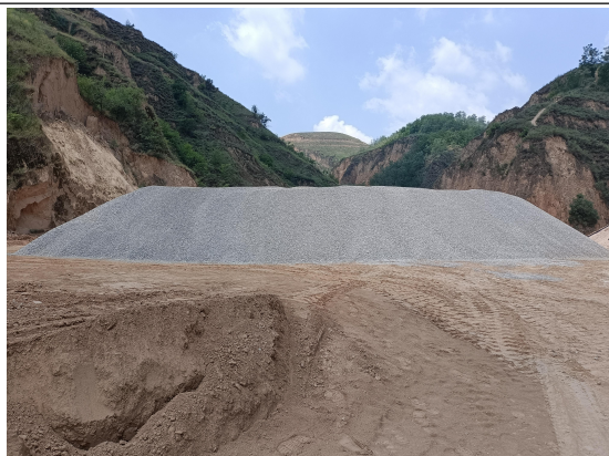
项目石料堆场（后续整改）
