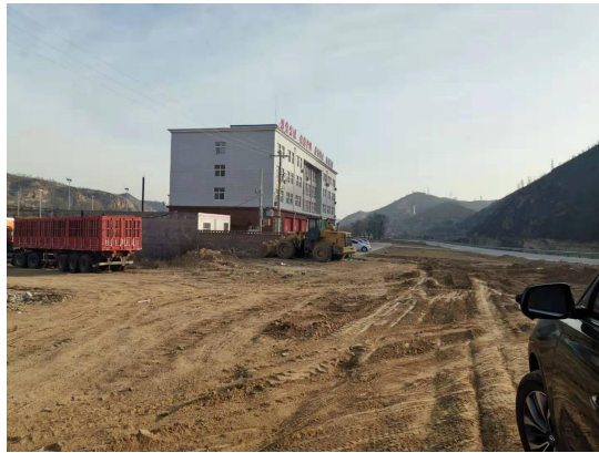
地块三西侧 子州县消防支队
