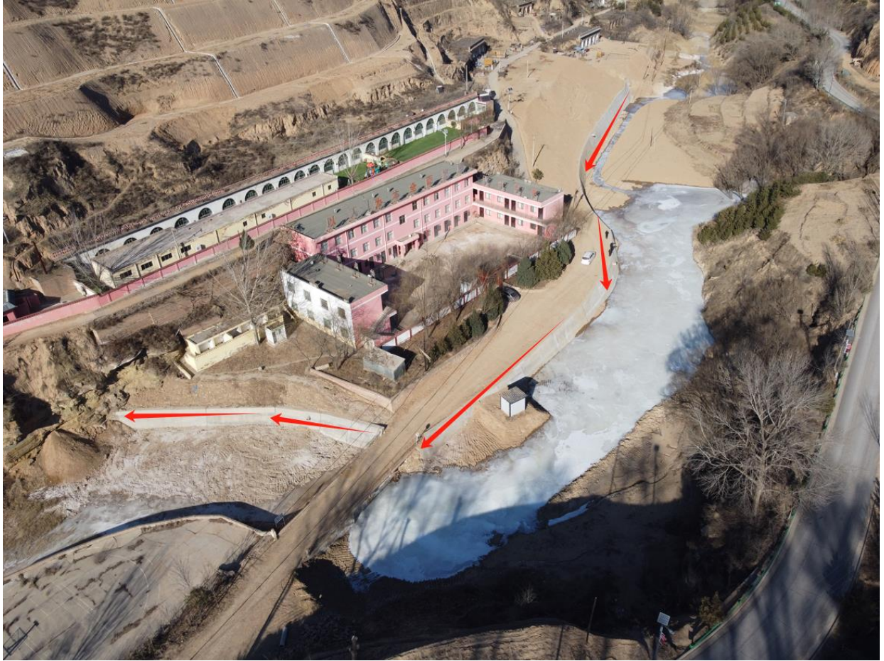
下游右岸李孝河中心小学治理河段（桩号 Z0+122~Z0+146/ Z0+146~Z0+221）航拍图
