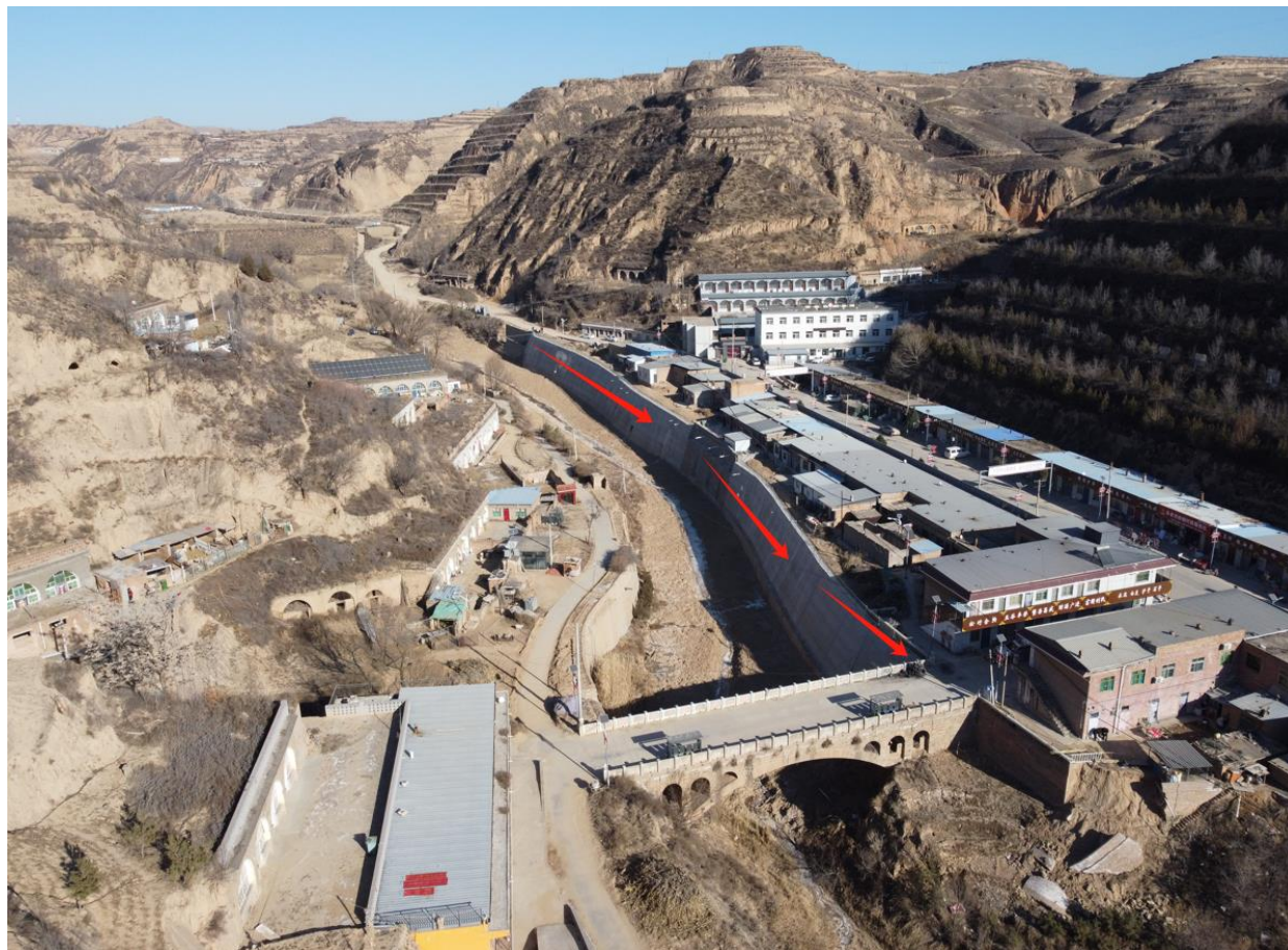
上游左岸居民区治理河段（桩号 Z0+000~Z0+122）航拍图
