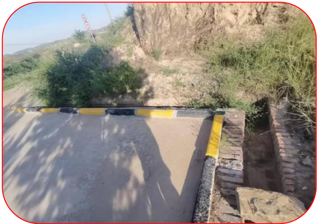
现有排水沟现状
